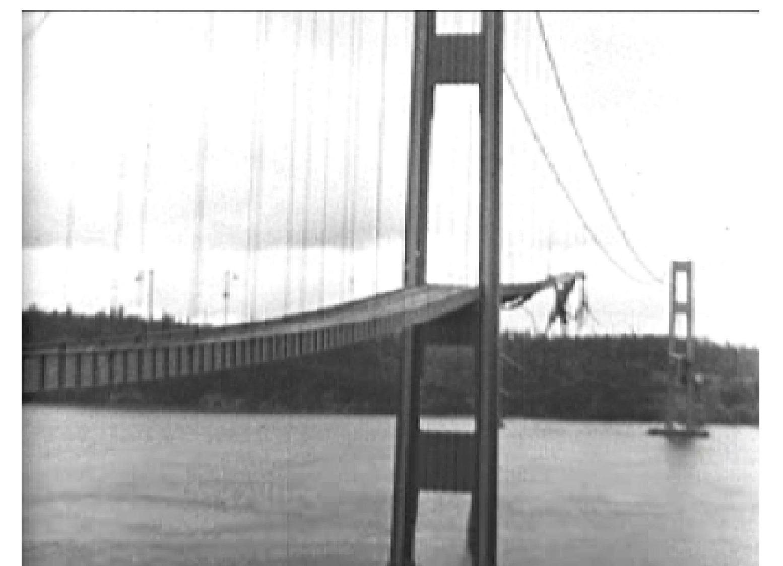
FIGURE 6: Pont du détroit de Tacoma écroulé en 1940 à cause d'un phénomène de résonance
